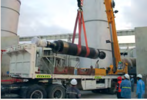
التوربين البخاري في محطة بركاء الثانية
