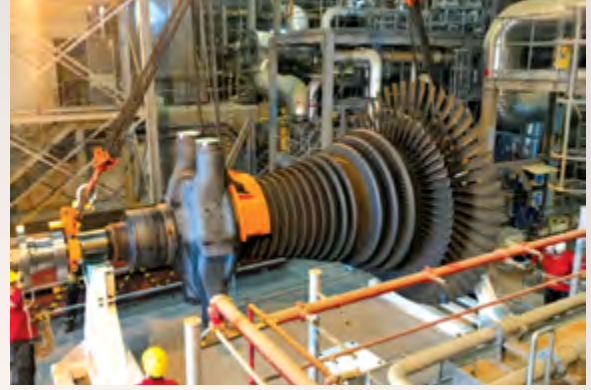
التوربين البخاري في محطة بركاء الثانية
